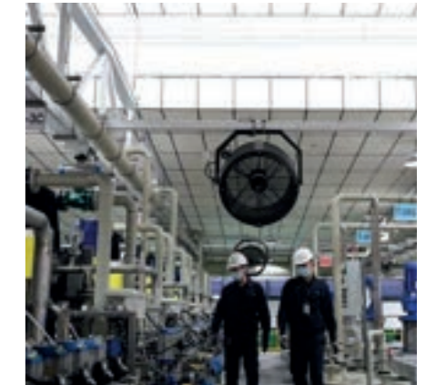
Batterijfabriek TES in Rotterdam
